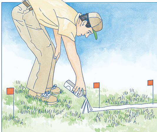
Перед копанием траншеи разметьте систему полива с помощью флажков и аэрозольной краски.
